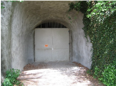
Galleria del campo di concentramento di Überlingen
